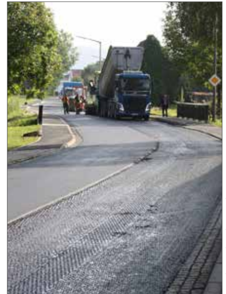
Bahnhofstraße Iphofen: Einbau einer neuen Decke unter halbseitiger Sperrung
