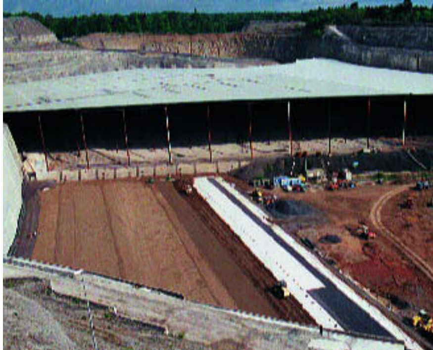
Deponie Wirmsthal (Mai 1997) Im Vordergrund wird gerade der Einlagerungsbereich 4a vorbereitet.
