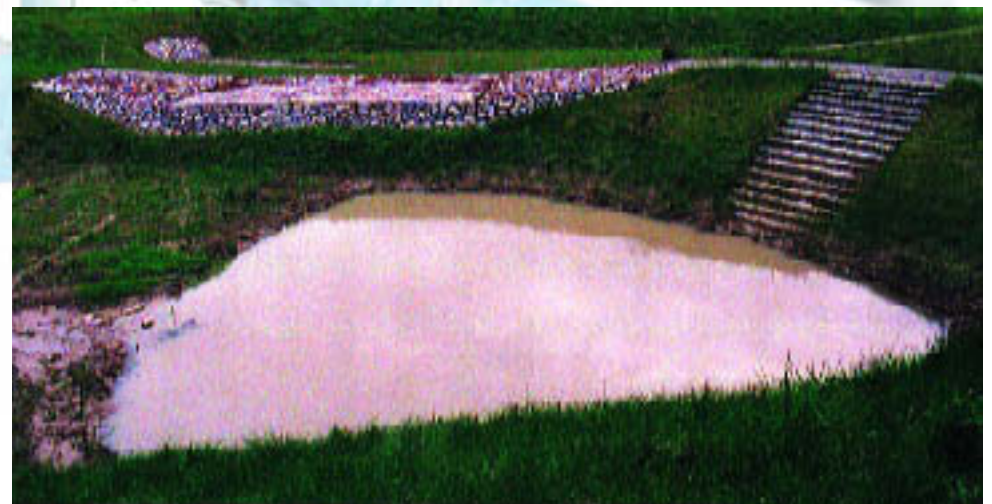
Regenrückhaltebecken für unbelaste- tes Oberflächenwasser. Fassungsvermögen: 4600 m 3
