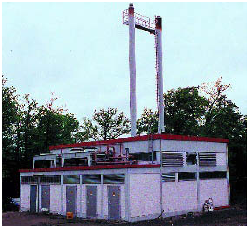
Im Blick das Blockheizkraftwerk
