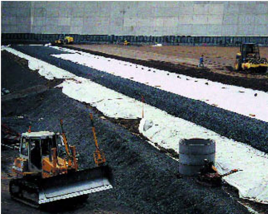
Errichtung der Abdichtungssysteme im Bauabschnitt 4a. Im Hintergrund Aufbau der Basisabdichtung aus vier Lagen Lehm zu je 25 cm Dicke.
