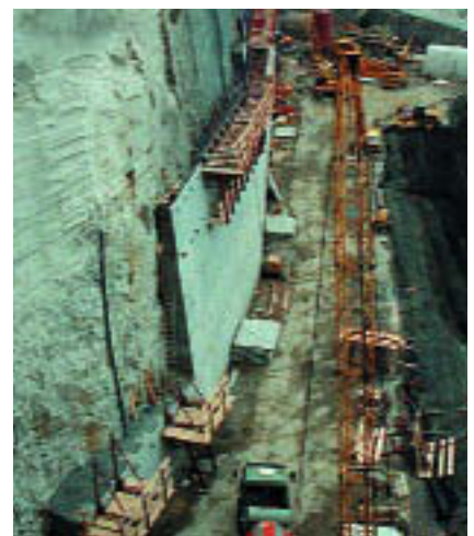
Bild rechts: Filigranplatten werden auf die Drainageschicht an der Felswand angebracht.
