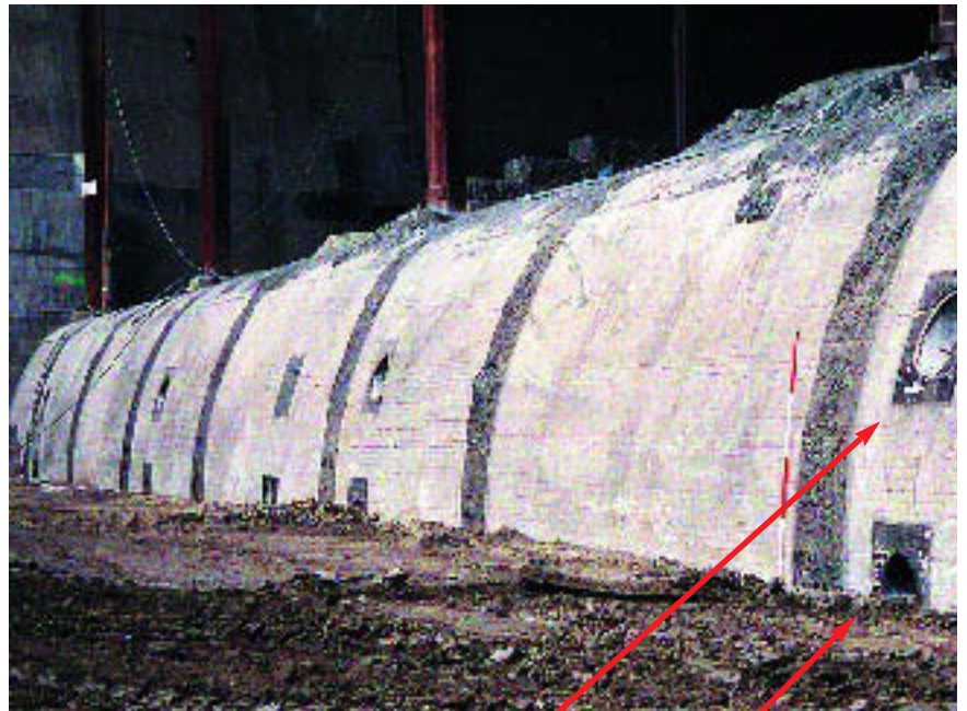
240 m langer Kontrollgang mit oberen und unteren Einlauföffnungen der Sickerwasser- und Kontrolldrainagerohre.
