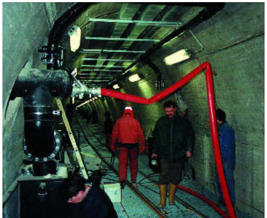
Arbeiten im Inneren des Kontrollganges. Links im Bild ein Sickerwasserdrainagerohr.
