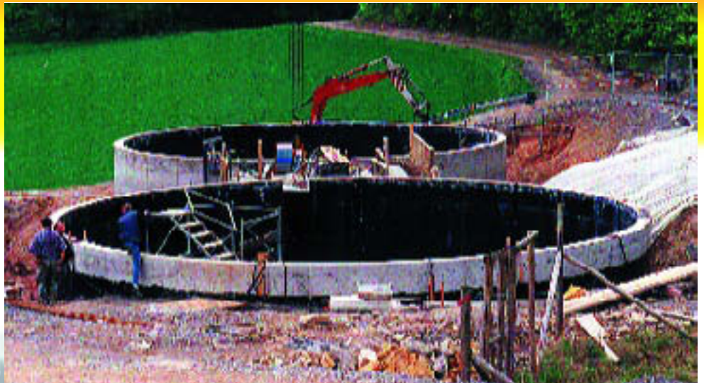
Sickerwasserspeicherbecken im Bau. Fassungsvermögen: je 850 m 3
