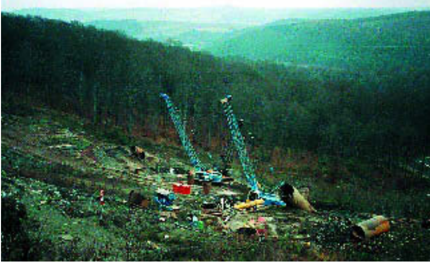
Blick auf die Sanierungsarbeiten mit dem Zentralschacht und den Bohrungen für die Ringdrainage
