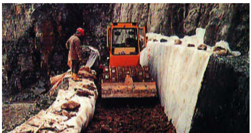
Im Bild: Einbau der Lehmschicht in Lagen von je 25 cm. Der Arbeiter steht auf den Drahtschotterkästen (Gabionen).
