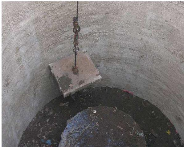
Abbildung 19: Verdichtung des Verfüllmaterials mittels Stahlplatte
