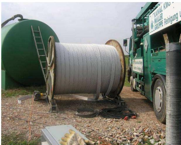
Abbildung 24: Trommel mit Wickelrohr-Profilstreifen
