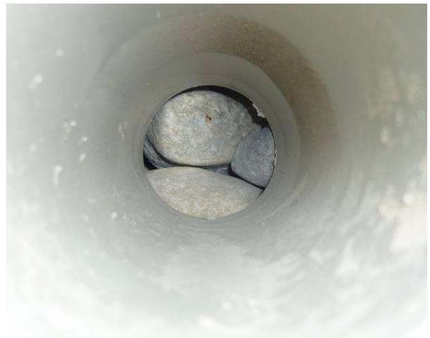
Abbildung 15: Blick aus einer Drainageöffnung auf den Drainagekies 50/150
