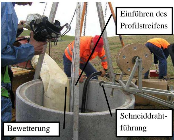
Abbildung 28: Einführen des Profilstreifens und des Schneiddrahtes in den Schacht D10a
