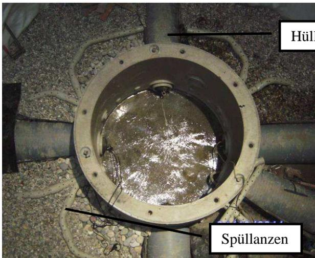
Abbildung 16: Schachtunterteil (Drainageschacht) mit Hüllrohren und Spüllanzen
