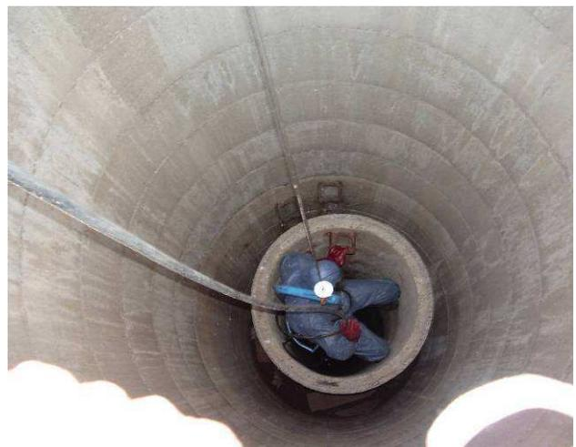
Abbildung 29: Ablassen eines Monteurs in den Zielschacht D11 alt
