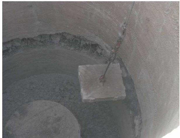
Abbildung 20: Teilrückbau des Spritzbetonverbau durch Aufbrechen mit Stahlplatte (Zwiesler-Methode)
