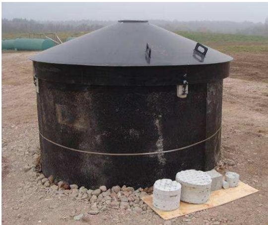
Abbildung 15: Erneuerter Sickerwasser-Drainageschacht mit Betonprobekörpern
