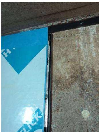
Abbildung 37: Klickplatten mit Montageleisten
