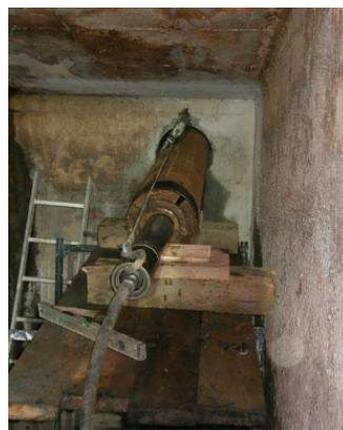
Abbildung 28: Installation und Ausrichtung der Erdramme im Sickerwassertank
