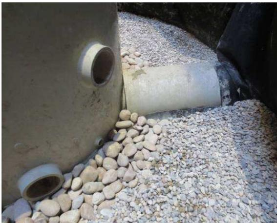
Abbildung 10: Abgestufter Drainagekies um Schachtunterteil mit eingebautem Hüllrohr
