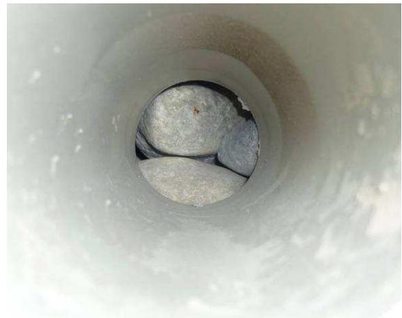
Abbildung 11: Blick aus einer Drainageöffnung auf den Drainagekies 50/150
