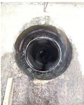
Abbildung 29: Eingerammtes Stahlrohr
