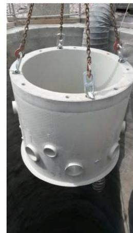
Abbildung 9: Setzen des fertigen Schachtunterteils
