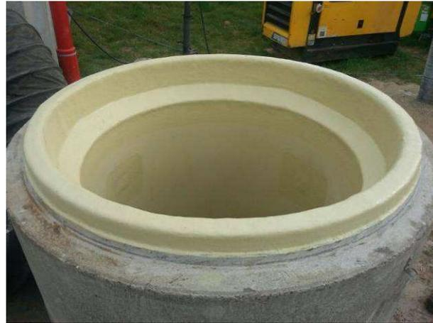
Abbildung 34: Anschluss an Betonschacht
