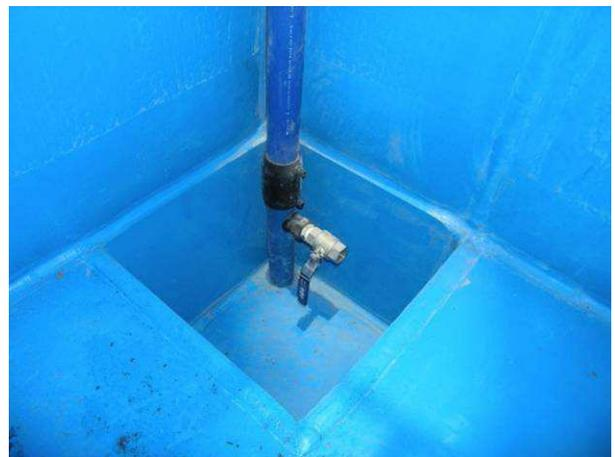
Abbildung 38: Pumpensumpf, Kontrollrohr
