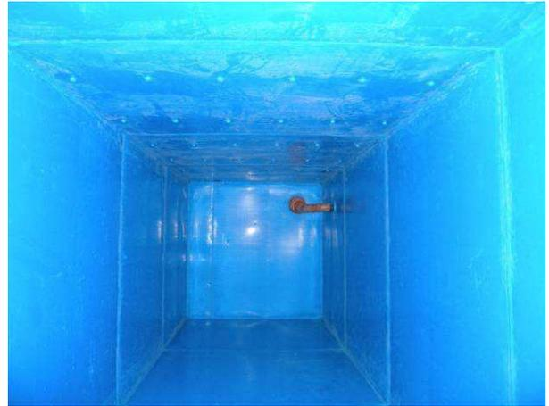
Abbildung 36: ...nach der PE-Auskleidung
