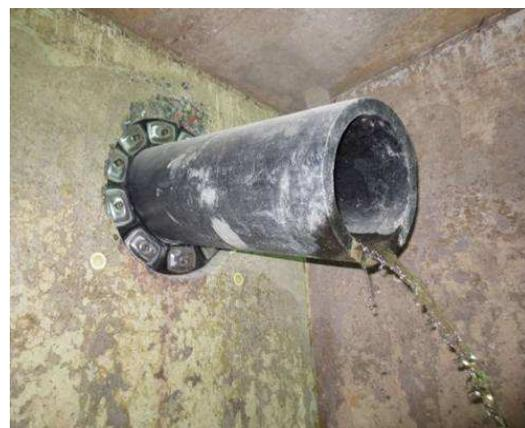
Abbildung 30: Neue PE-Verbindungsleitung
