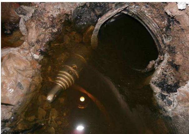
Abbildung 27: Ankunft der Pilotbohrung im Zielschacht D10a
