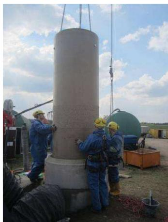
Abbildung 31: Setzen des GFK-Inliners
