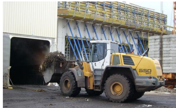
Befüllung eines Fermentertunnels neben Baustelle
